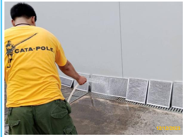
รูปที่ 3-5 การล้างทำความสะอาดเครื่องปรับอากาศ
