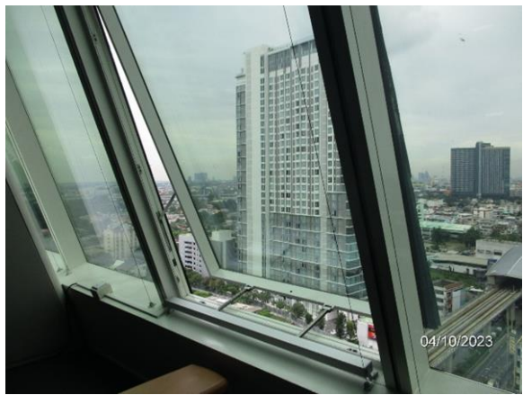
รูปที่ 3-8 เปิดช่องของอาคารบางจุดเพื่อการระบายอากาศ
